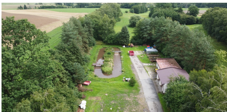
Obr. 16: Areál ČOV Lípa
