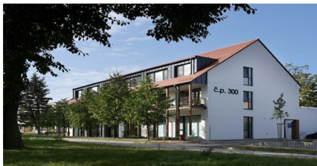
Obr. 20: Multifunkční dům Lípa č.p. 300
